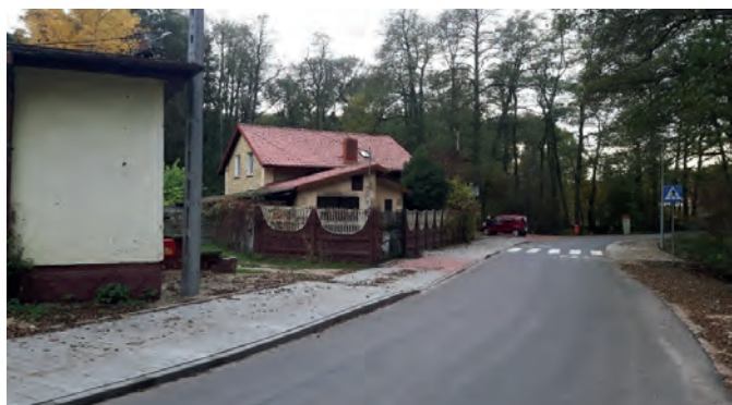
Przebudowa drogi gminnej w Konewce
