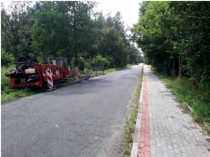
Budowa sieci wodociągowej na ul. Brzustowskiej
