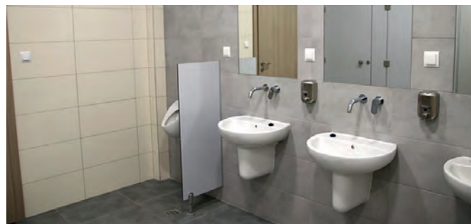
Pomieszczenia sanitarne w PSP w Inowłodzu
