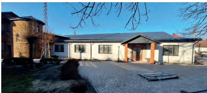
Prace budowlane OSP w Inowłodzu, widok od ul. Tuwima
