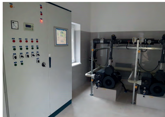
Wnętrze budynku przepompowni ścieków w Zakościelu
