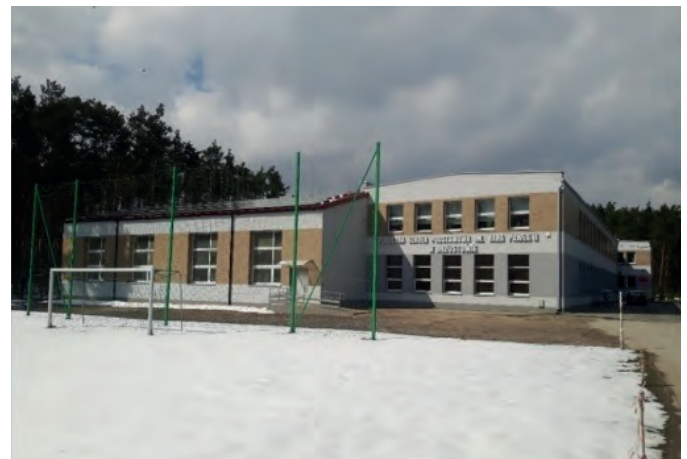
Budynek PSP w Brzustowie po remoncie
