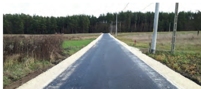
Przebudowa drogi gminnej w Brzustowie
