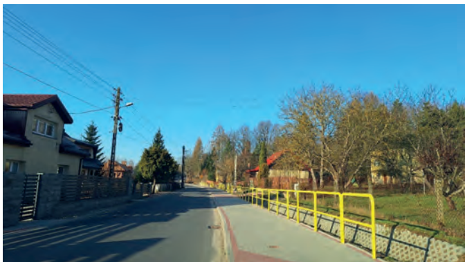
Nowo wybudowana droga, odcinek Zakościele
