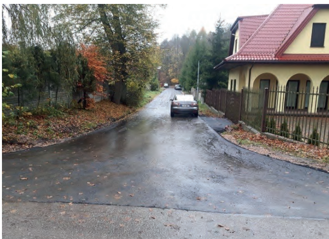
Przebudowa drogi gminnej w Spale
