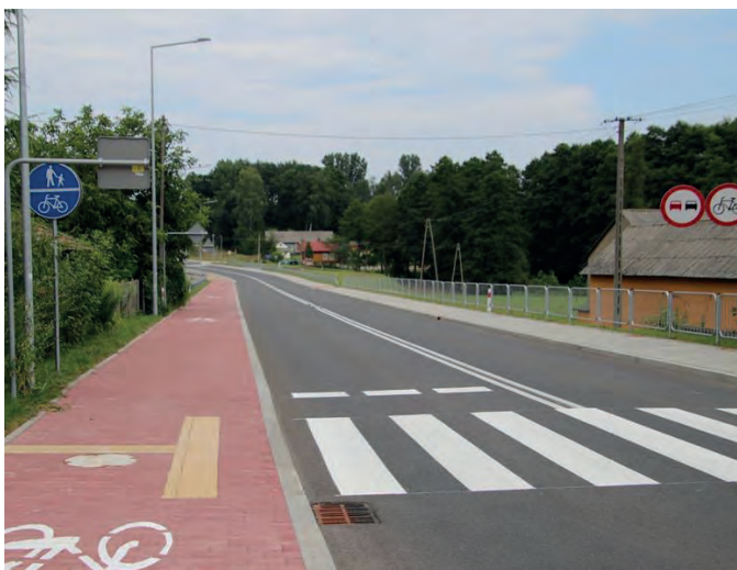
Przebudowana droga woj. w Liciężnej
