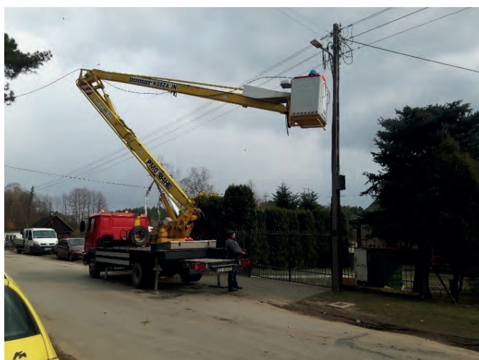
Wymiana opraw oświetleniowych na terenie gminy
