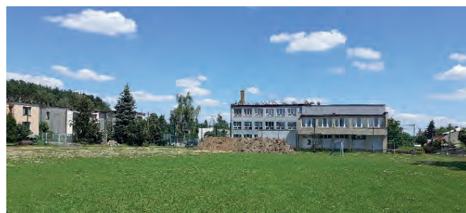
Prace budowlane przy PSP w Inowłodzu
