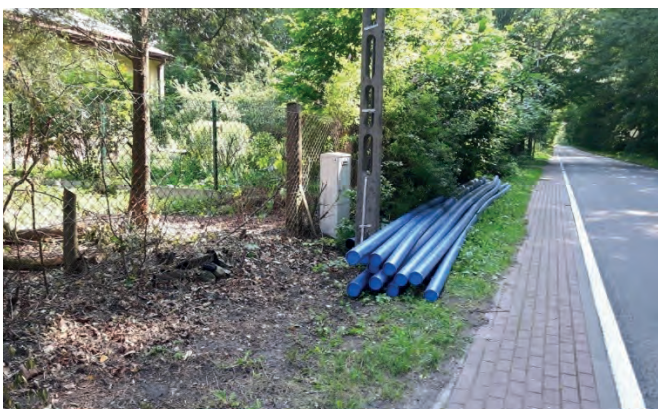
Budowa sieci wodociągowej w Spale przy ul. Gabrysiewicza
