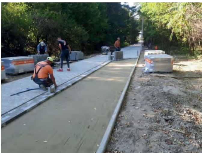
Prace budowlane na ul. Hermana
