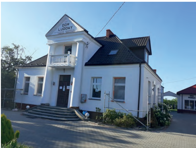
Nowa elewacja budynku Domu Ludowego w Królowej Woli
