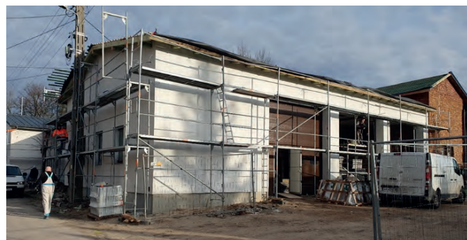
Prace budowlane przy OSP w Inowłodzu
