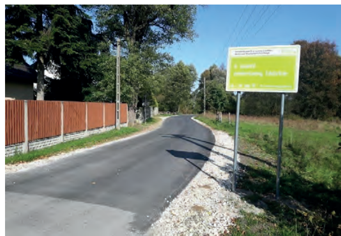
Modernizacja drogi gminnej w Żądłowicach
