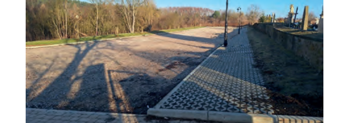
Parking przy ul. Hermana po przebudowie
