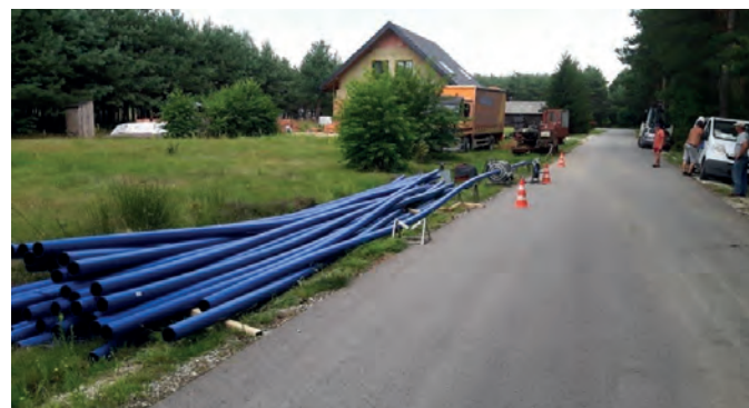
Budowa sieci wodociągowej
