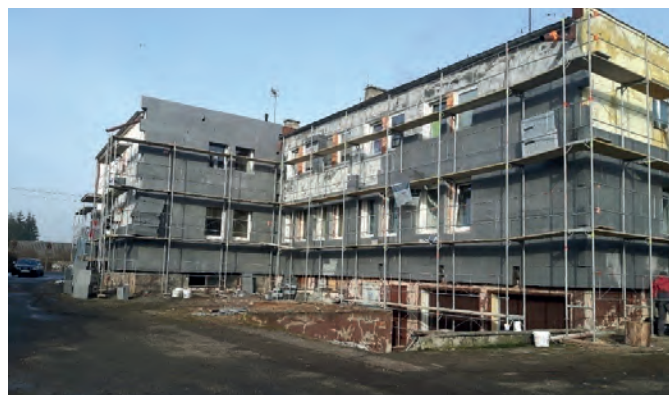
Prace budowlane przy ośrodku zdrowia w Inowłodzu
