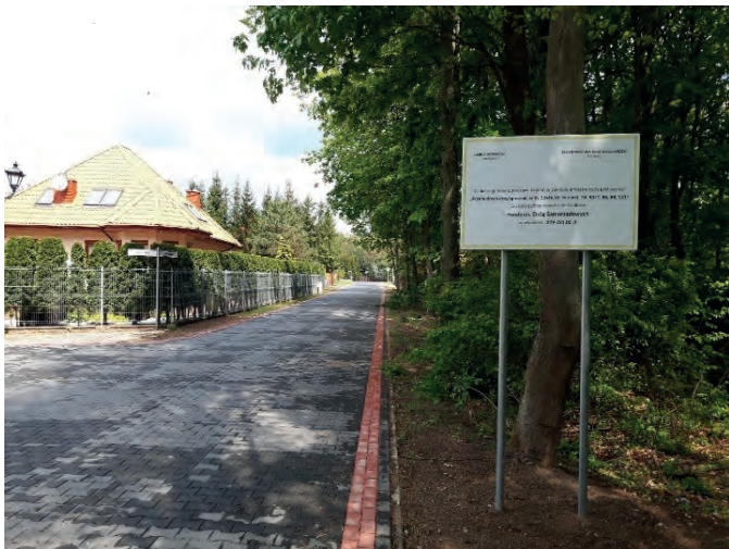
Przebudowa drogi gminnej w Spale
