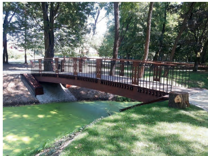
Kładka prowadząca na wyspę w parku wodnym w Spale
