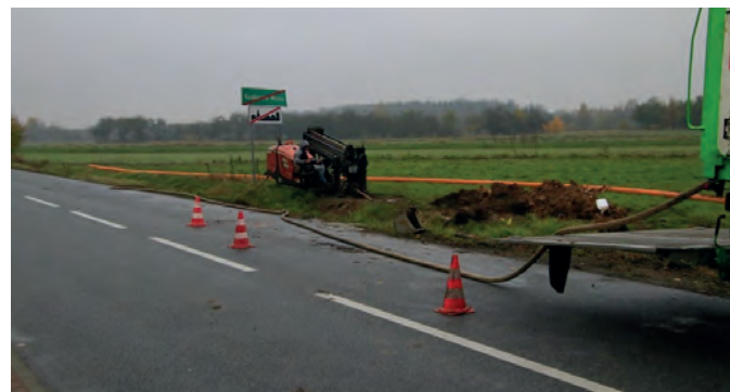
Budowa sieci wodociągowej w Królowej Woli
