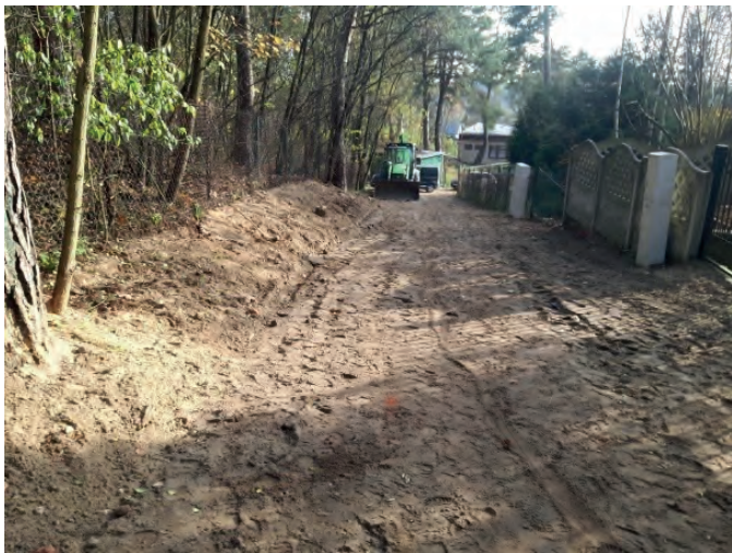
Budowa sieci kanalizacji w Zakościelu
