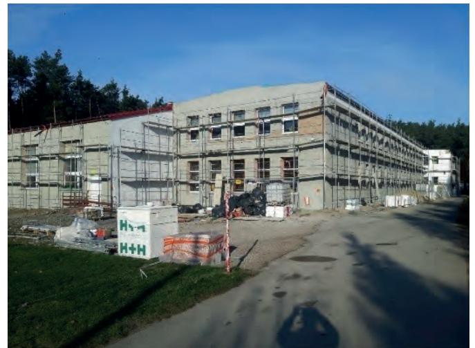
Prace budowlane przy budynku PSP w Brzustowie
