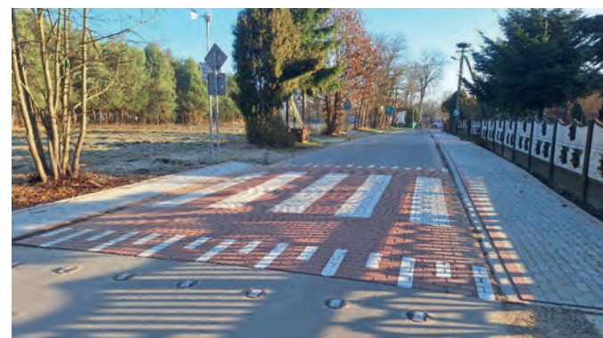
Nowo wybudowana droga, odcinek w Żądłowicach
