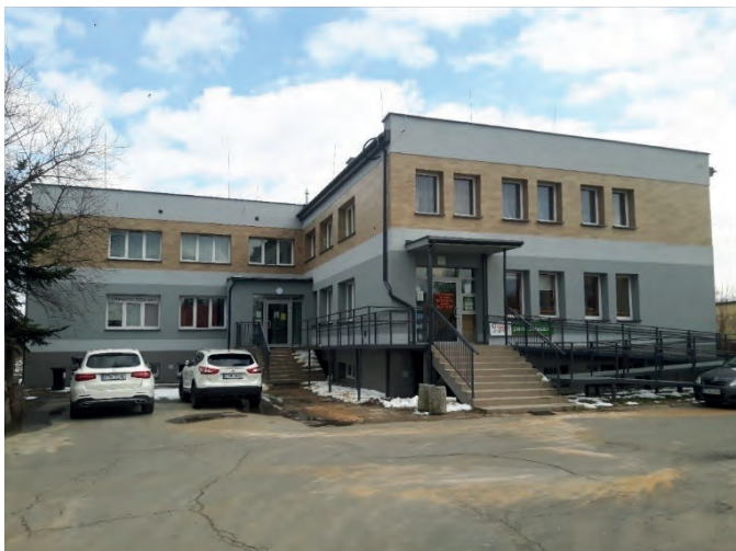
Ośrodek Zdrowia w Inowłodzu po remoncie
