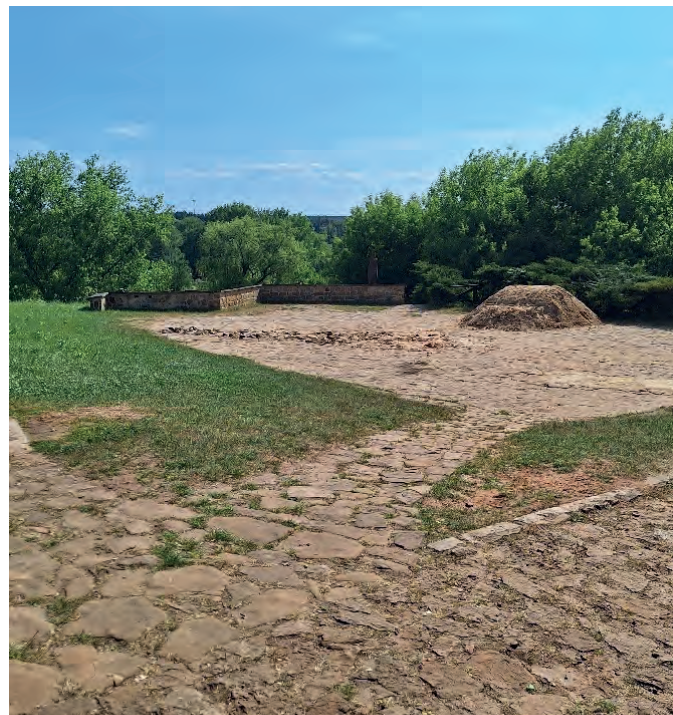
Prace budowlane na parkingu przy ul. Hermana
