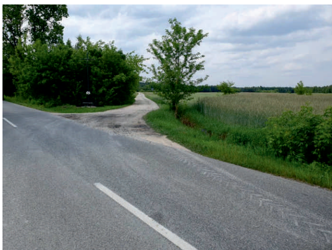
Odcinek remontowanej drogi gminnej
