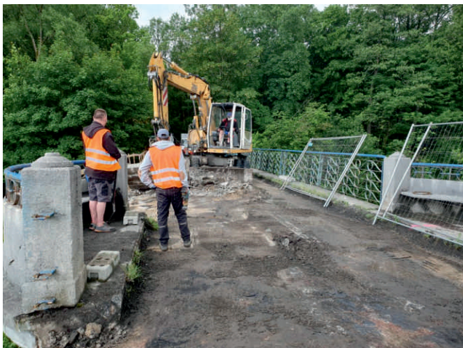
Remont zabytkowego mostu w Spale
